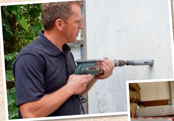
Das Material wird durch das sogenannte Kleinlochverfahren eingeblasen. Für den Einfüllstutzen werden in die Fugenkreuze der Außenseite, Einblasöffnungen mit 18 bis 24 mm gebohrt, welche nach dem Einblasen den vorhandenen Fugen angepasst und somit fast unsichtbar verfügt werden.
