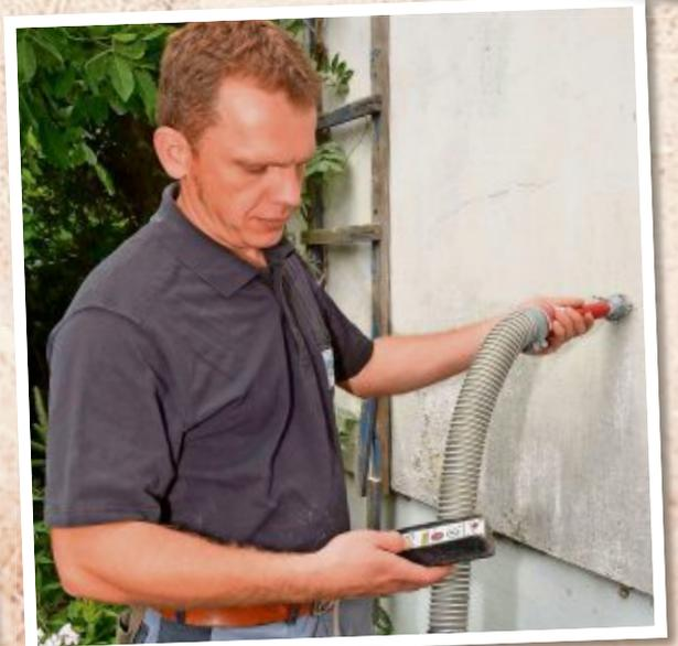
Das Einblasen geschieht mittels einer speziell für Dämmstoff hergestellten Einblasmaschine. Wichtig ist die Kontrolle des Füllungsgrades, denn nicht ausgefüllte Hohlräume können die Dämmwirkung deutlich herabsetzen und stellen Wärmebrücken dar, die anfällig für Schimmelbefall sein können. Im Bereich von Heizkörpernischen und Fensterlaibungen sollte der Wohnraum durch flankierende Dämmplatten ausgekleidet werden. Fotos Ulich
