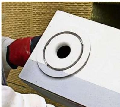
**Mittlerweile gibt es spezielle Module, die in die Wärmedämmung eingesetzt werden.** Fotos: Saint-Gobain Weber
