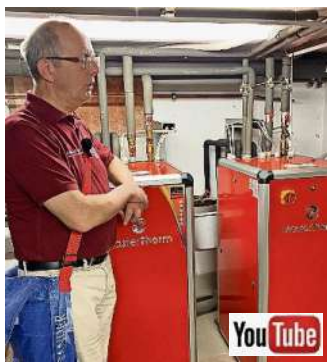
Claus Uhde zeigt eine Luftwärmepumpe-Außenaufstellung.
